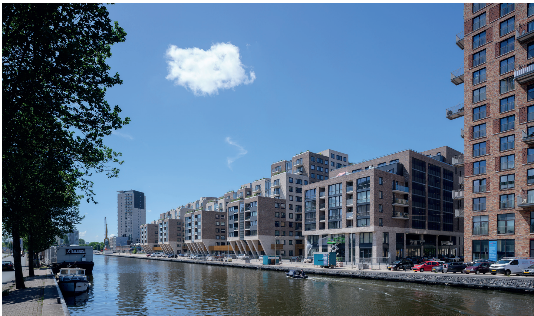
Nieuw-Laakhaven Den Haag (Zes X Zes Visuele Communicatie)
